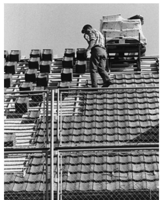
Bild 6: An Schrägdächern bietet eine Dachdeckerschutzwand mit Gittern einen idealen Schutz vor Absturz von Personen, Gegenständen und Materialien.
